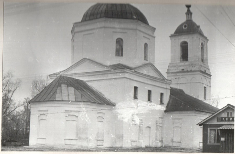
инв. № 65231 Северо-восточный фасад
